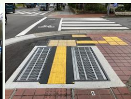
点字ブロックの修繕
