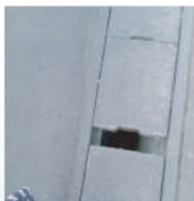
下水の隙間にふた (川北)
